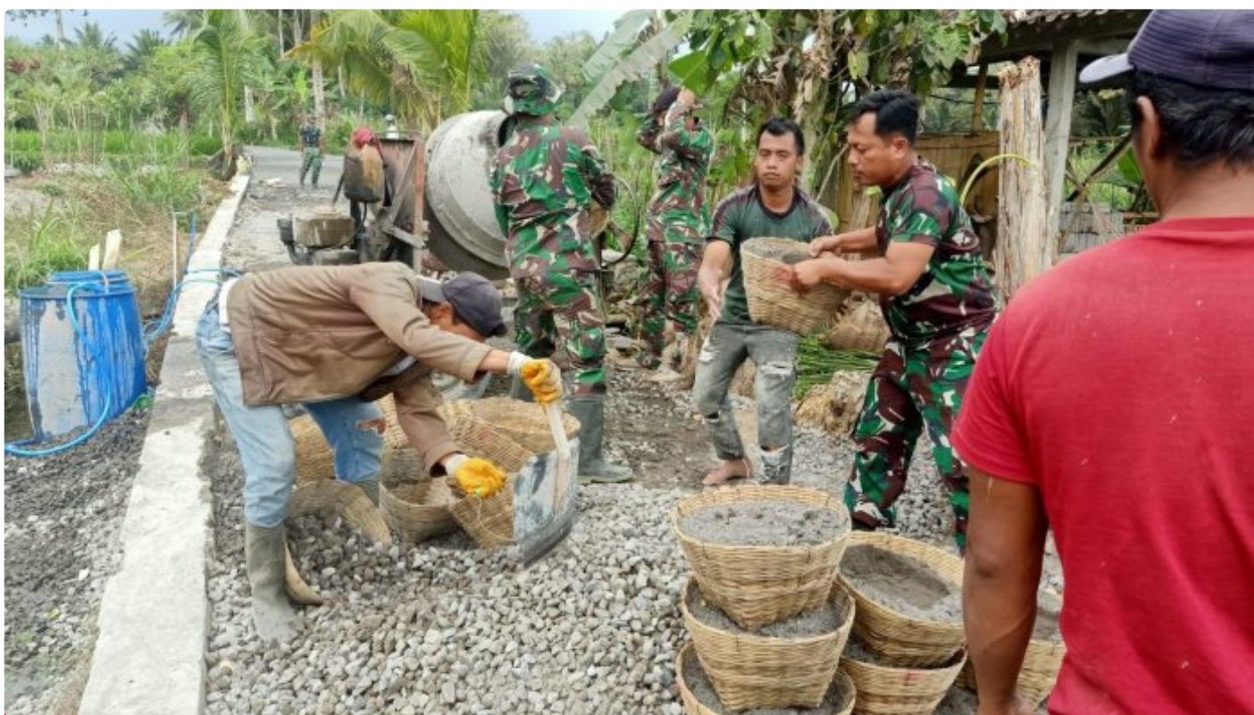
Satgas TMMD Sengkuyung bersama warga bahu membahu mengerjakan cor blok jalan
